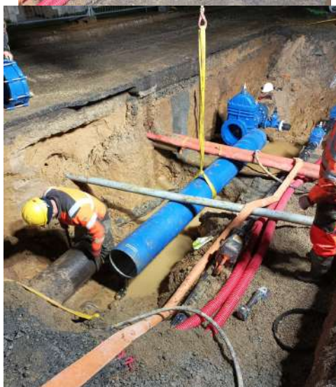
En haut à droite : mise en place d'une vanne de sectionnement sur le feeder
